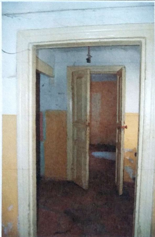
Точка №23. Помещение 2-го этажа в осях 6-7
