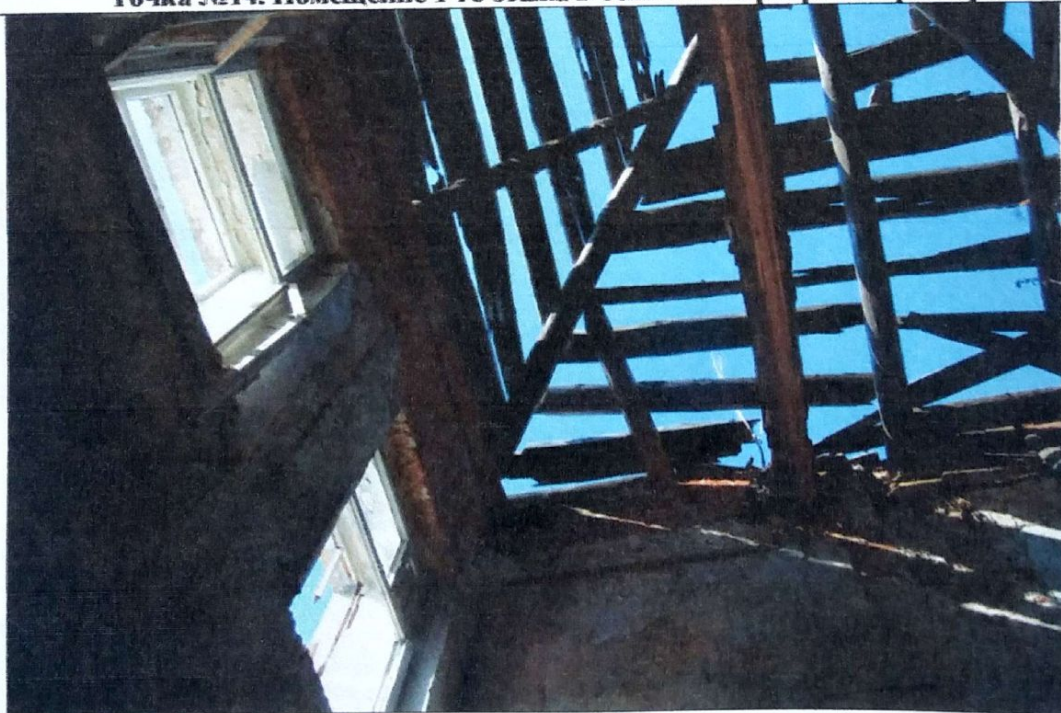
Точка №15. Помещение 1-го этажа в осях 4-5. Перекрытия разобраны, вид на 2-ой этаж и стропильные конструкции
