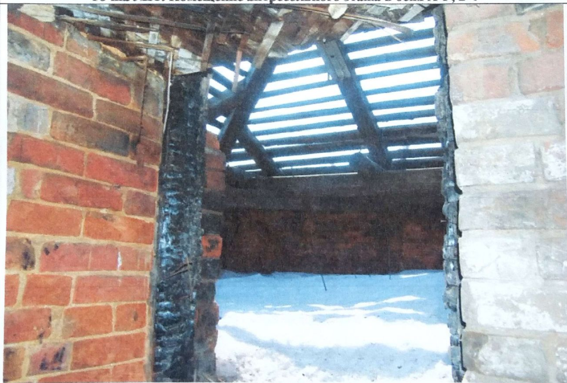
Точка №34. Помещение антресольного этажа в осях А-Г, 2-4
