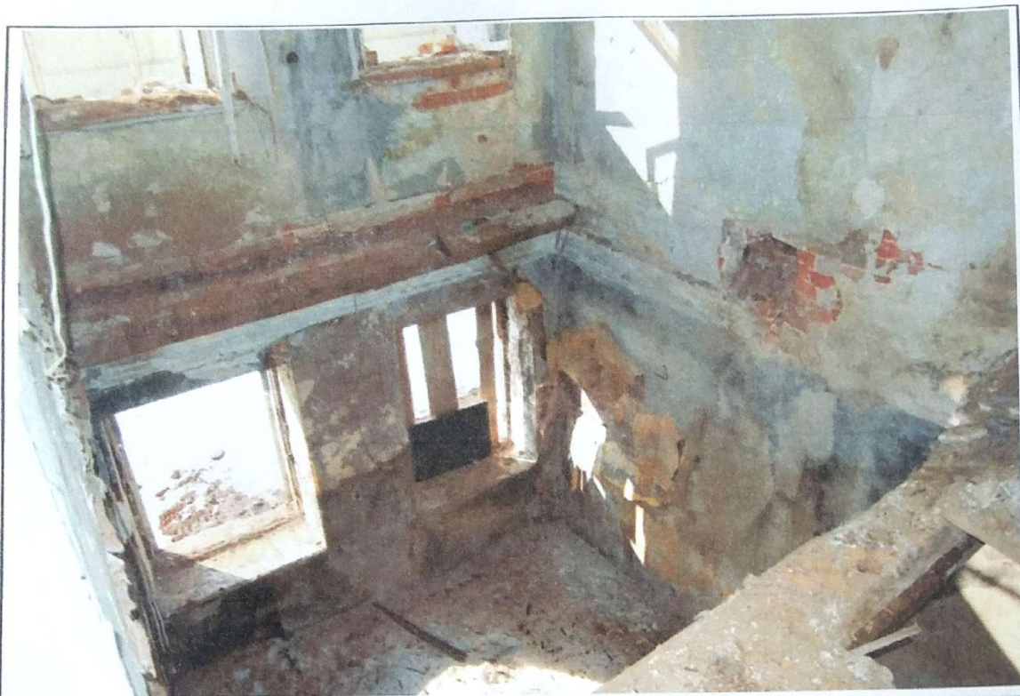
Точка №26. Помещение 2-го этажа в осях 4-5. Перекрытие разобрано.
