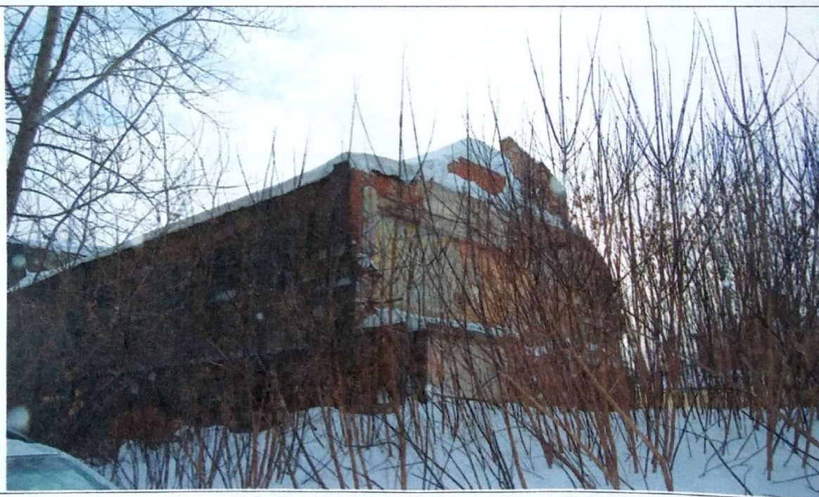
Точка №5. Вид на фасад (фрагмент) с ул. Нагорная
