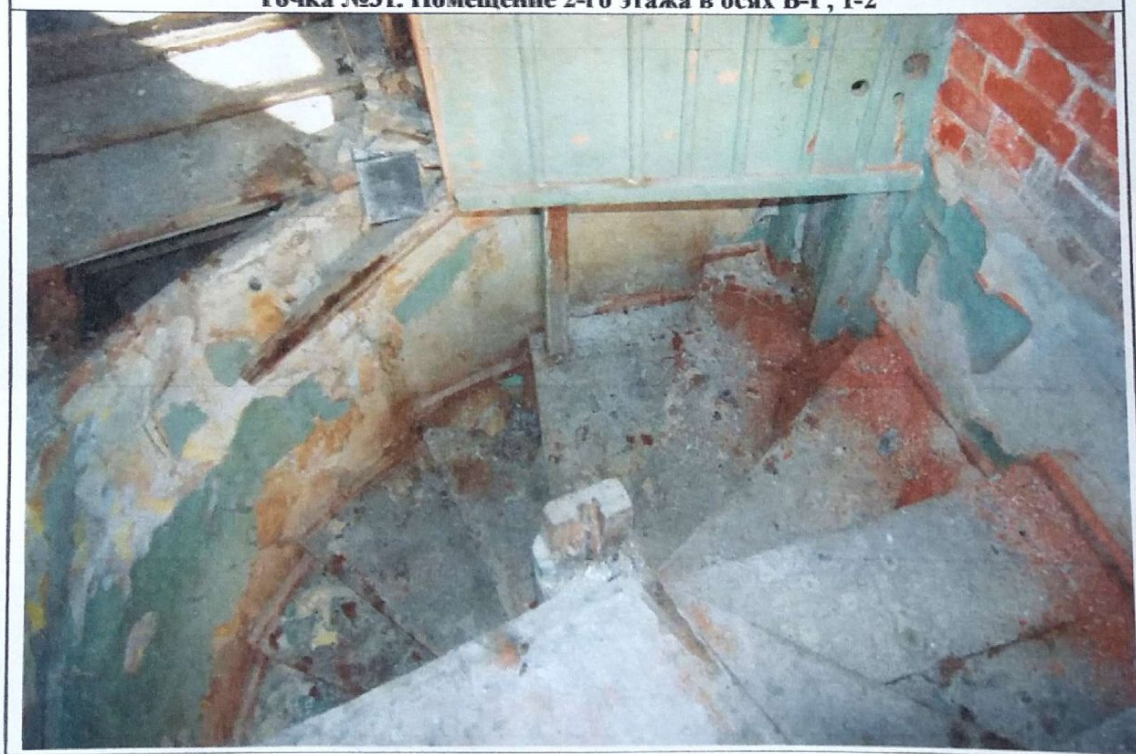
Точка №32. Вид на деревянную винтовую лестницу на антресольный этаж в осях 3-4
