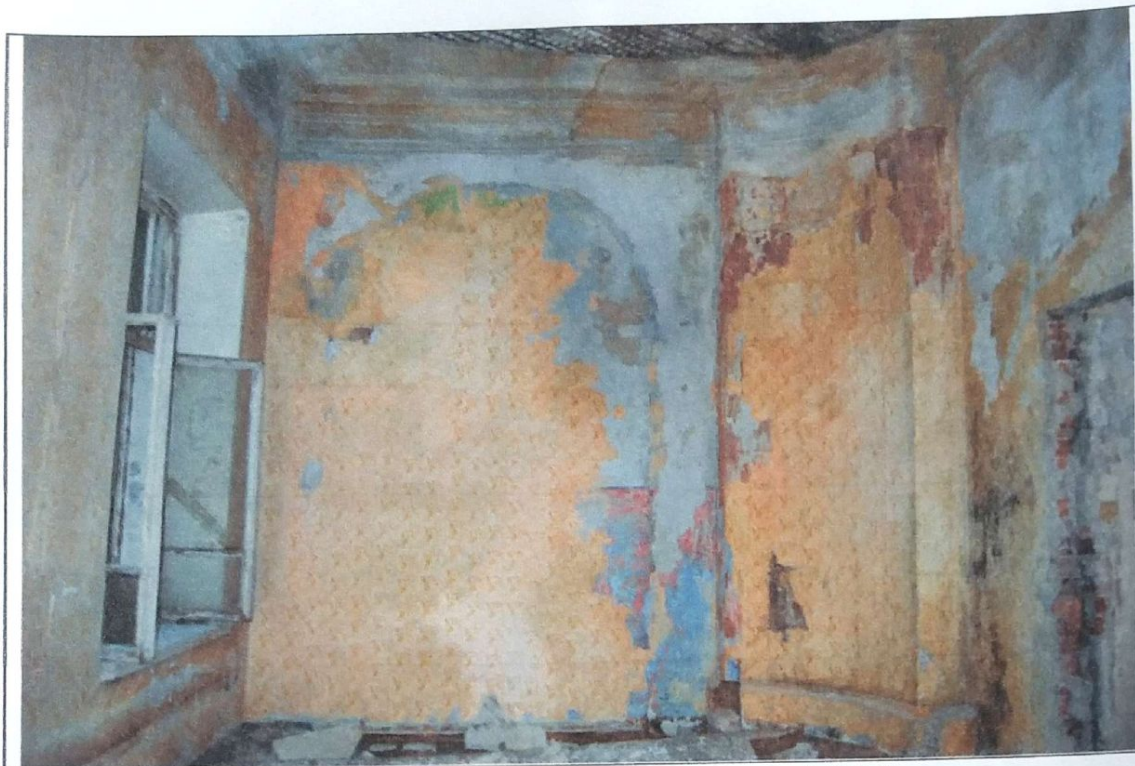
Точка №29. Помещение 2-го этажа в осях А-В,1-2
