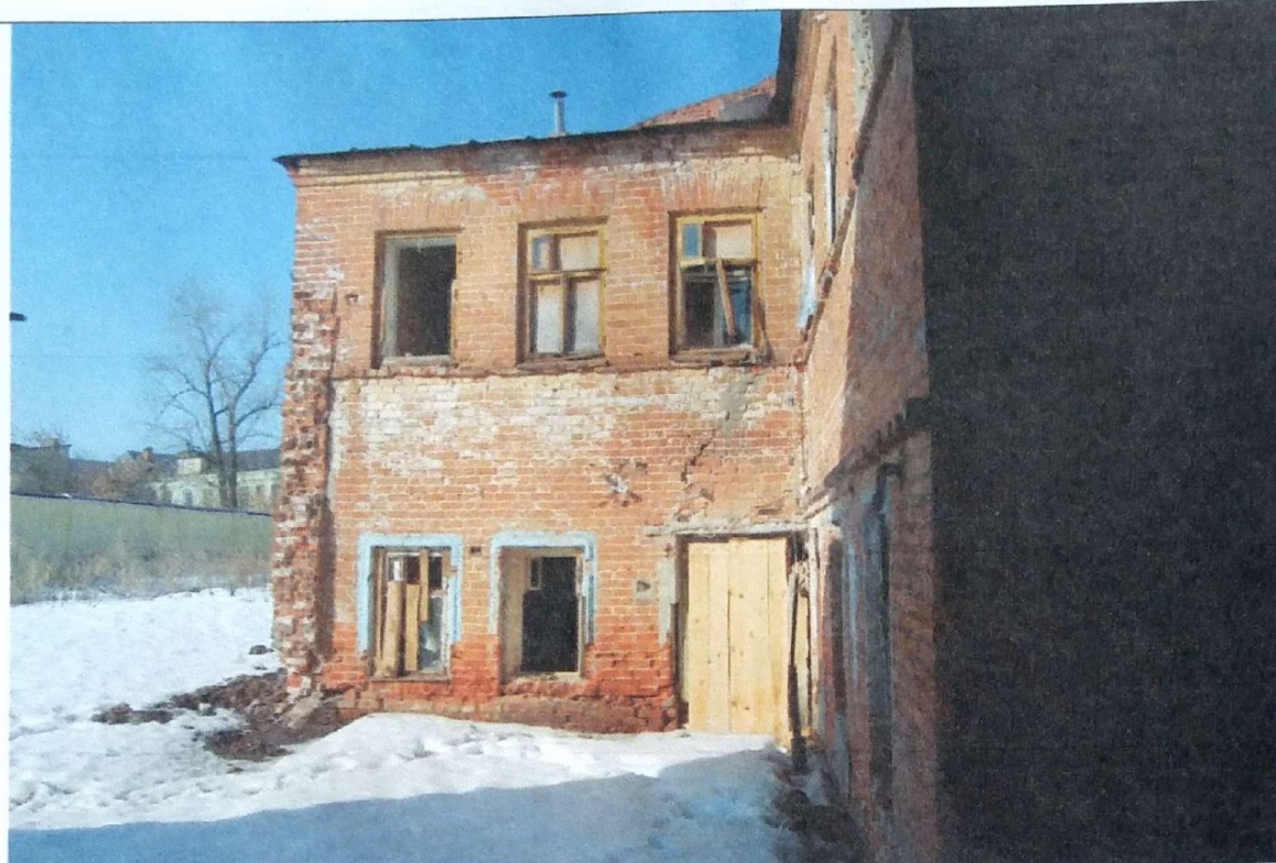
Точка №10. Вид на дворовый фасад (фрагмент)
