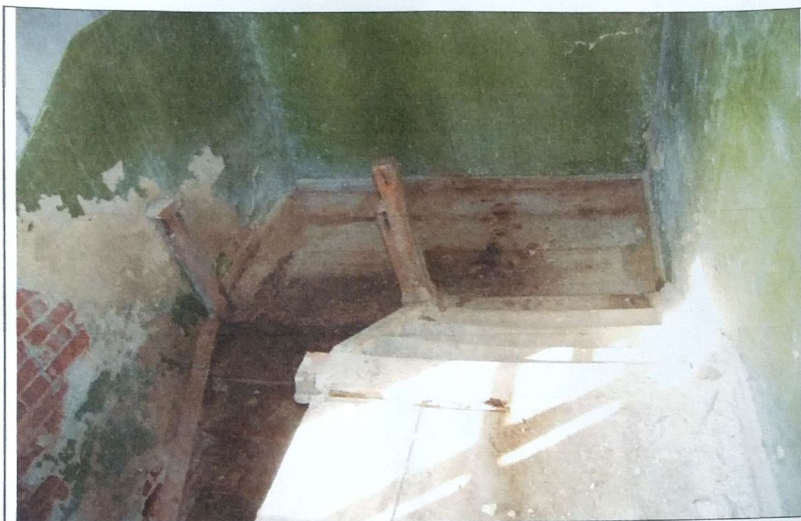
Точка №27. Вид на лестницу в осях Д-Г, 2-4
