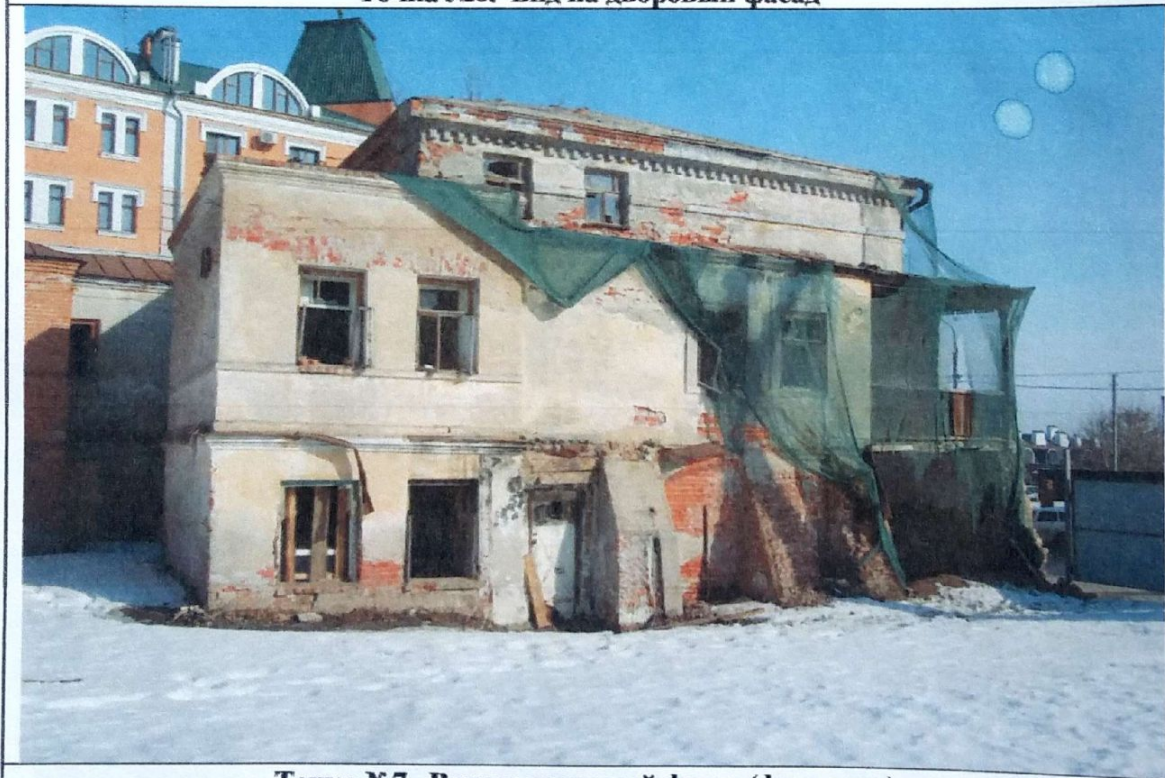
Точка №7. Вид на дворовый фасад (фрагмент)
