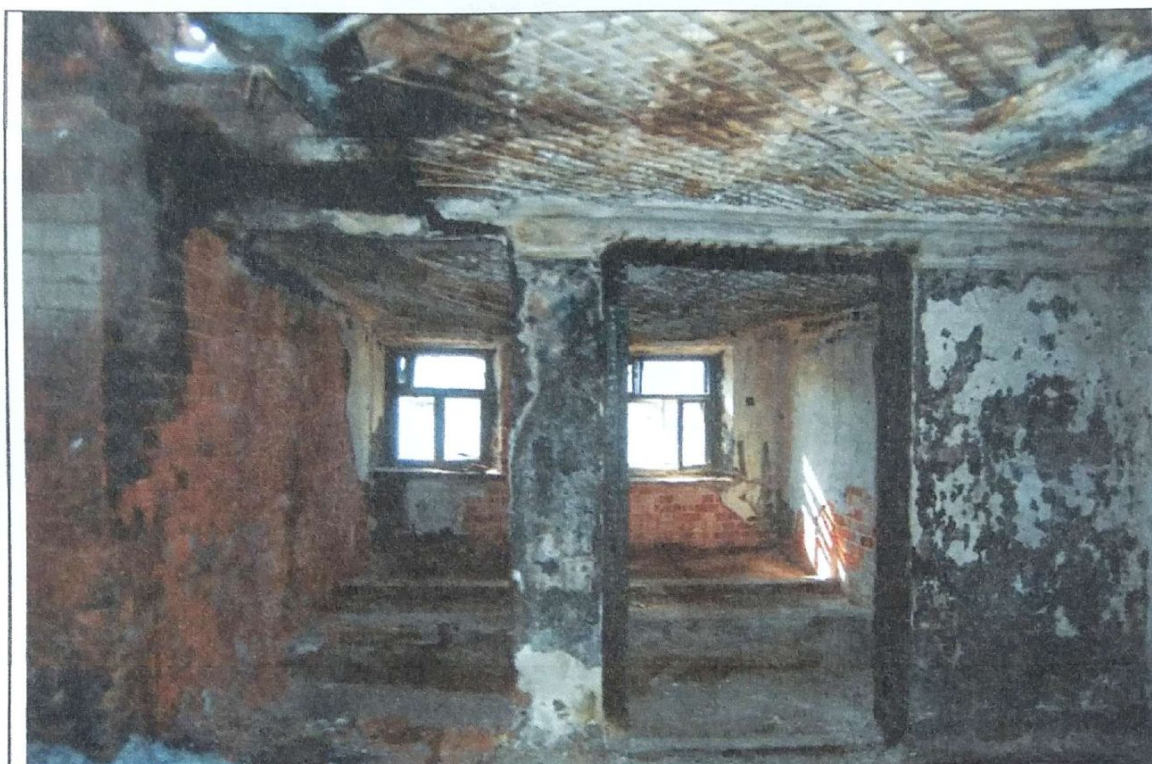
Точка №33. Помещение антресольного этажа в осях А-Г, 2-4
