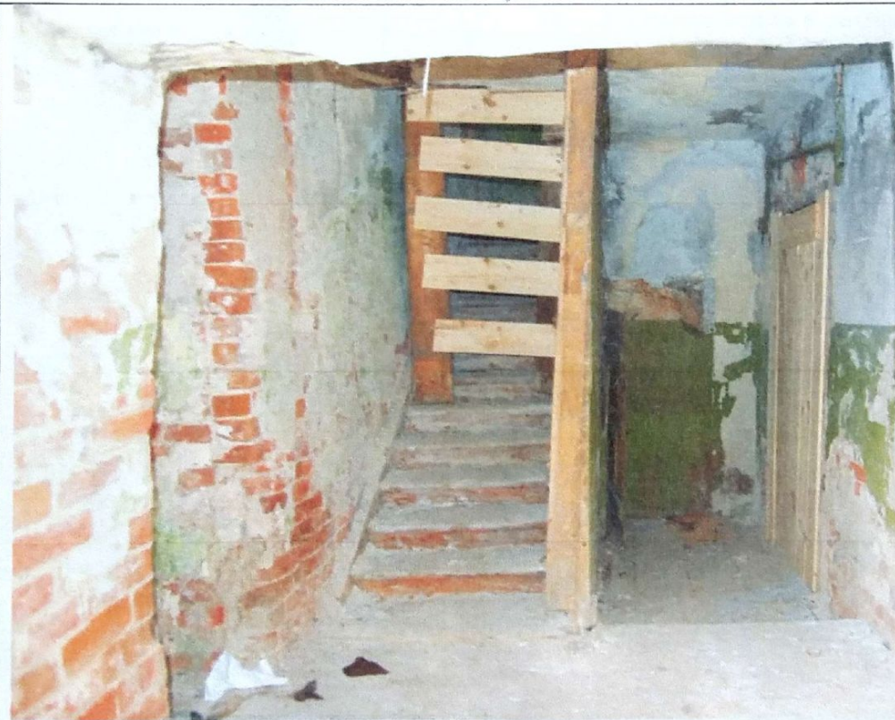
Точка №19. Помещение 1-го этажа „Лестница на 2-ой этаж
