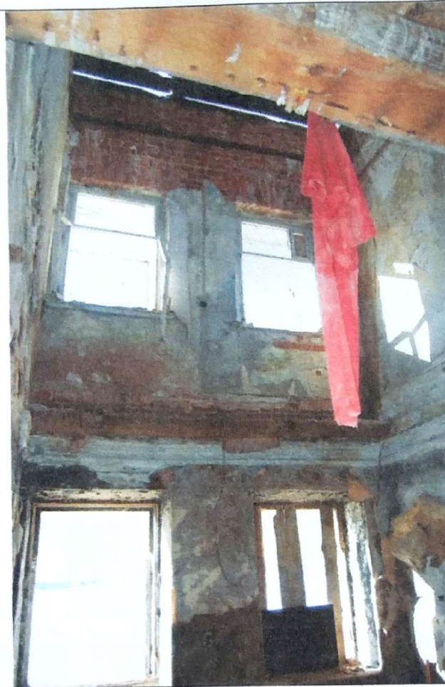
Точка №14. Помещение 1-го этажа в осях 4-5. Перекрытия разобраны
