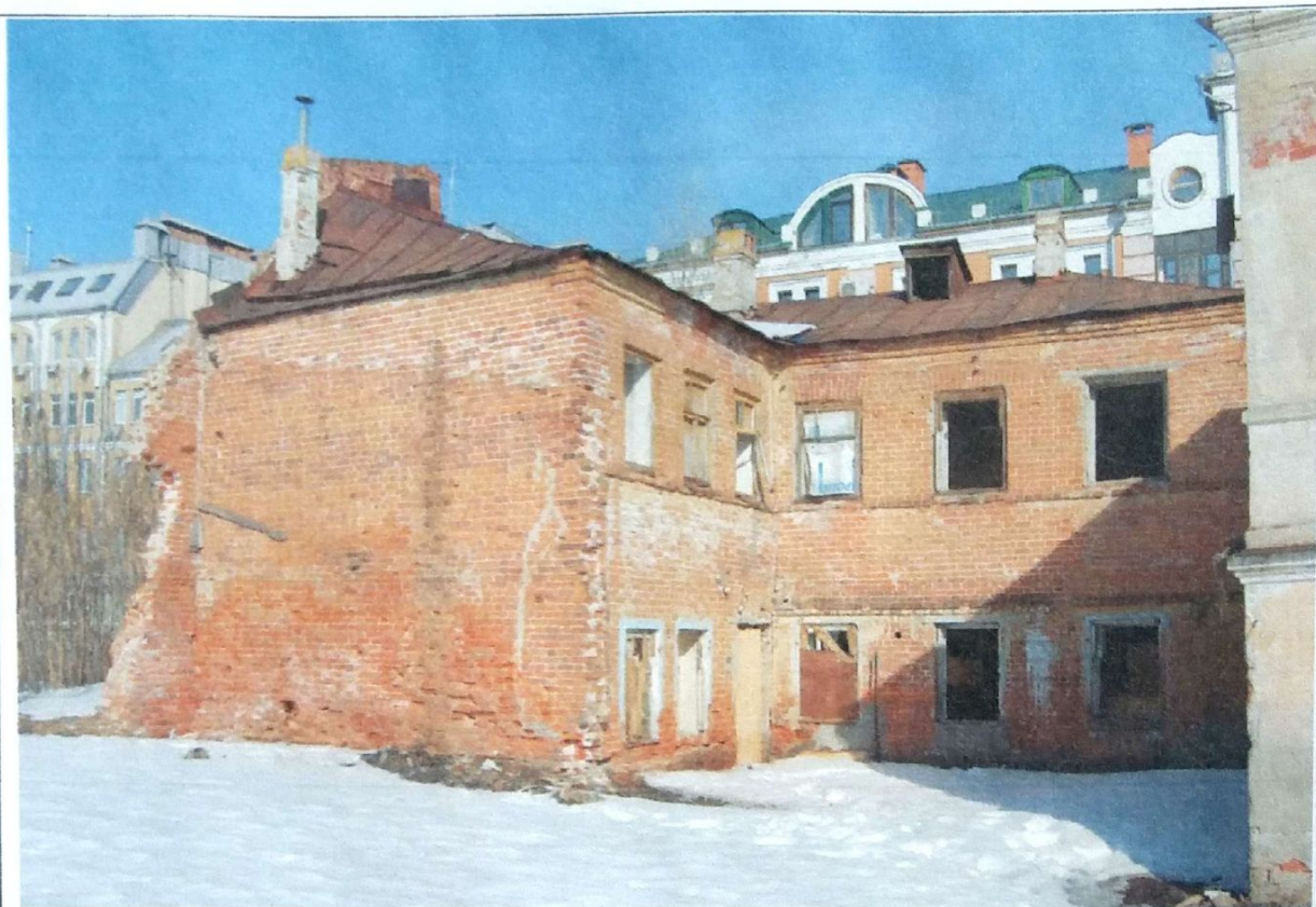
Точка №8. Вид на дворовый фасад (фрагмент)
