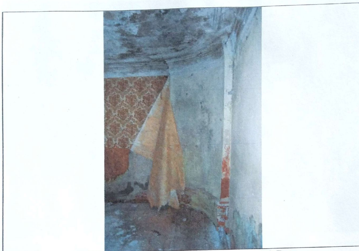
Точка №16. Помещение 1-го этажа в осях 1-2, А-В
