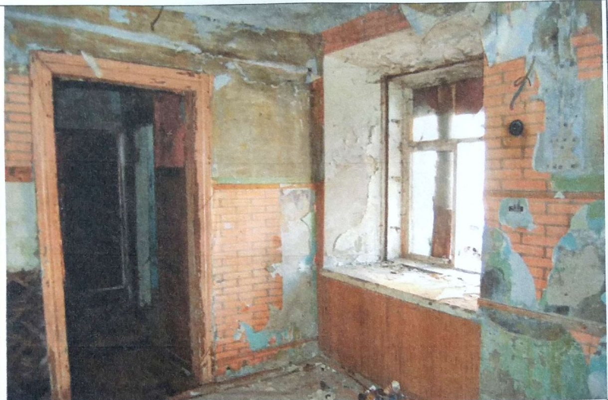
Точка №18. Помещение 1-го этажа в осях 2-4
