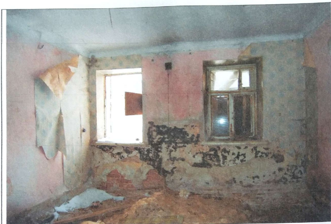
Точка №12. Помещение 1-го этажа в осях 6-7
