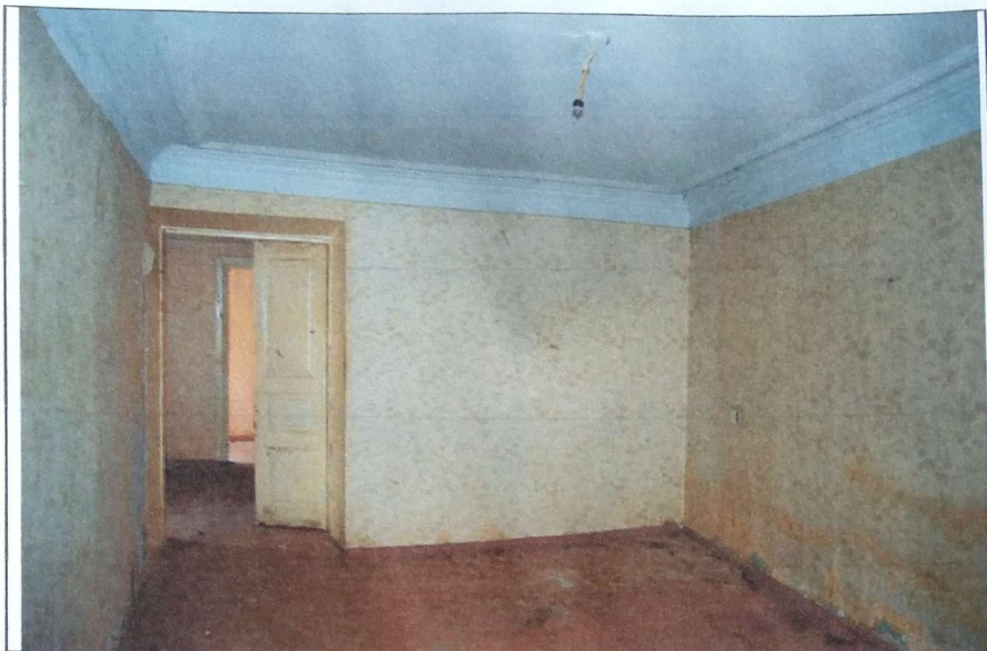
Точка №24. Помещение 2-го этажа в осях 7-8
