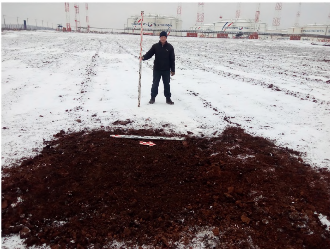
Илл. 84. Шурф №13. Рекультивация. Вид с В.
