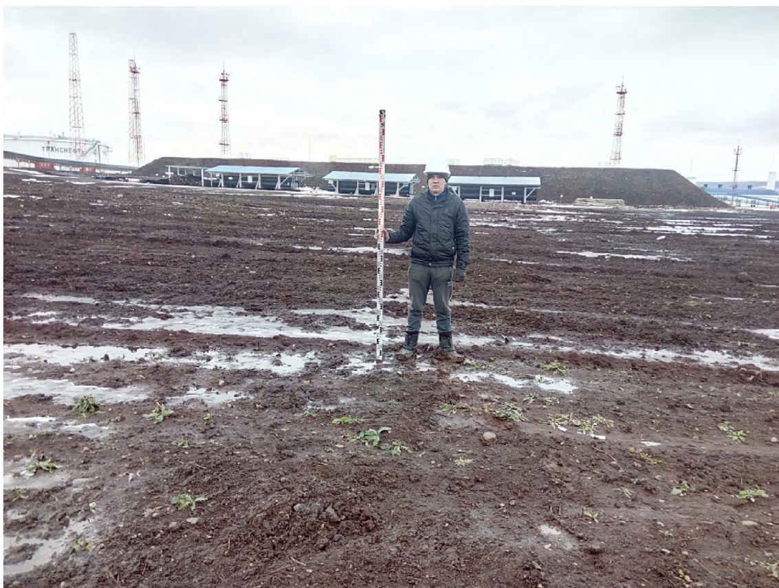
Илл. 45. Общий вид местности в районе расположения шурфа №6. Вид с Ю.
