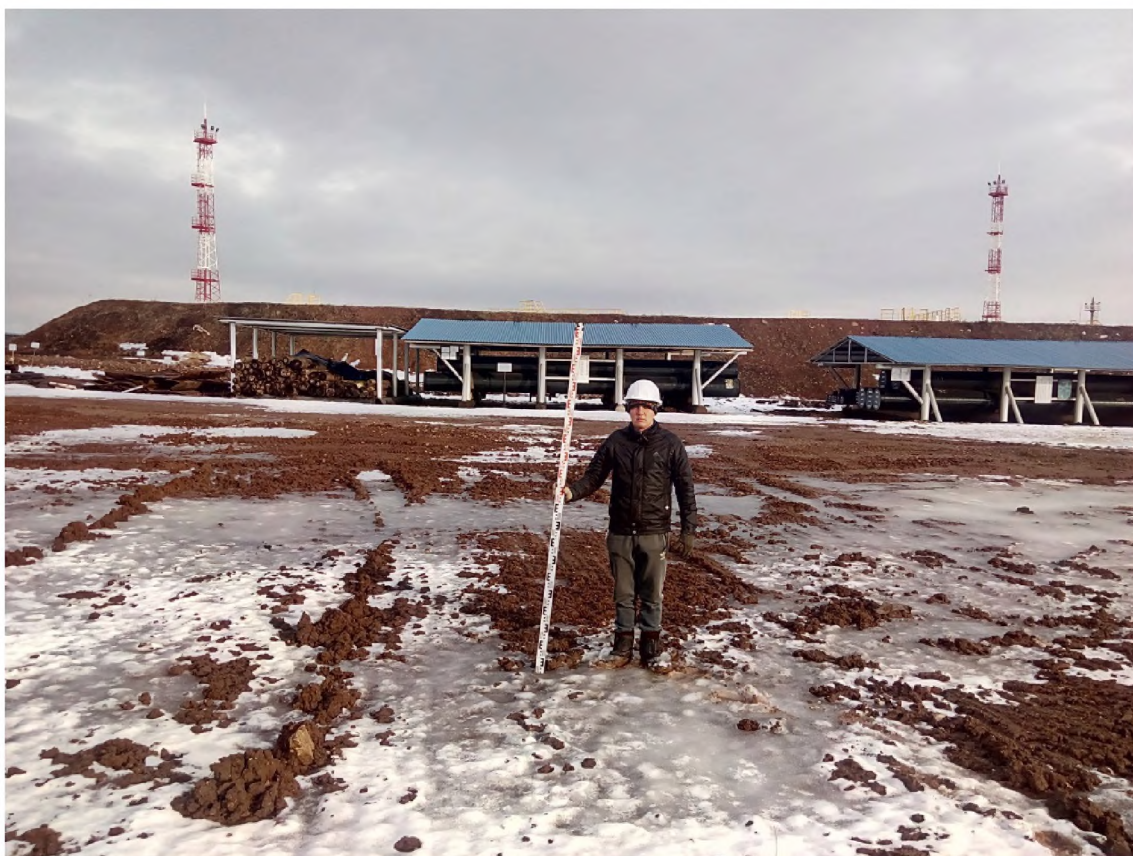
Илл. 25. Общий вид местности в районе расположения шурфа №2. Вид с Ю.
