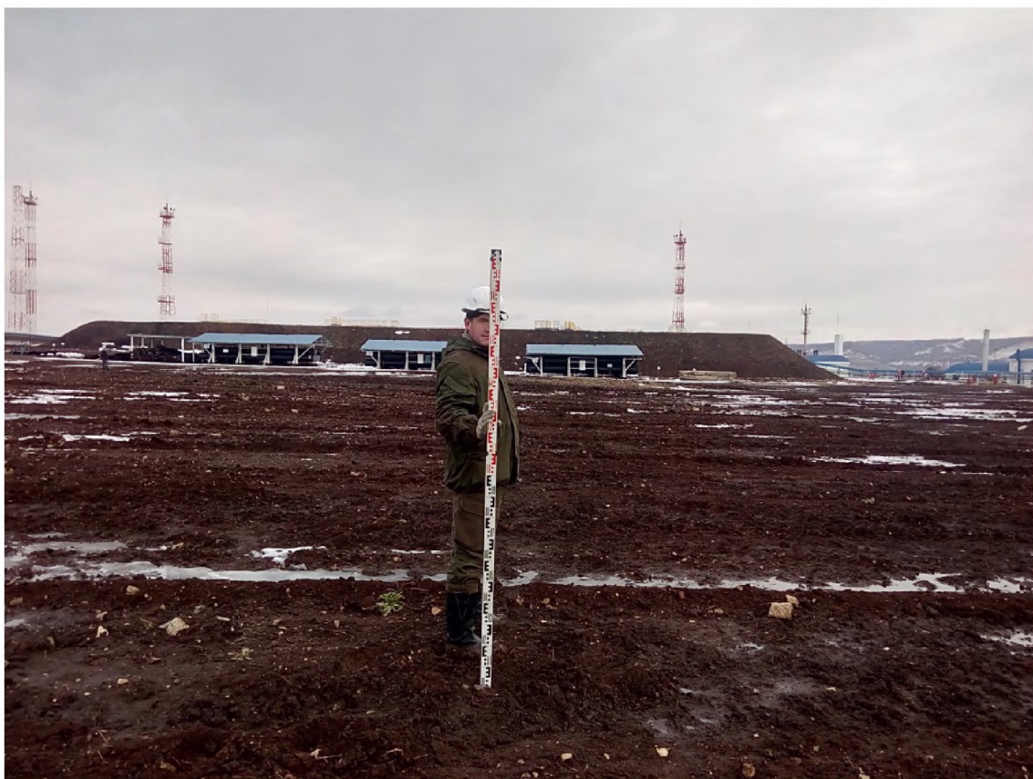
Илл. 30. Общий вид местности в районе расположения шурфа №3. Вид с Ю.
