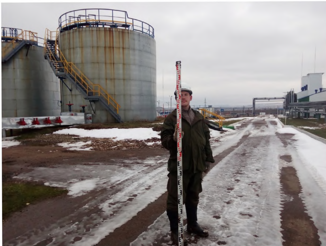
Илл. 15. Общий вид в районе исследования. Вид с З.
