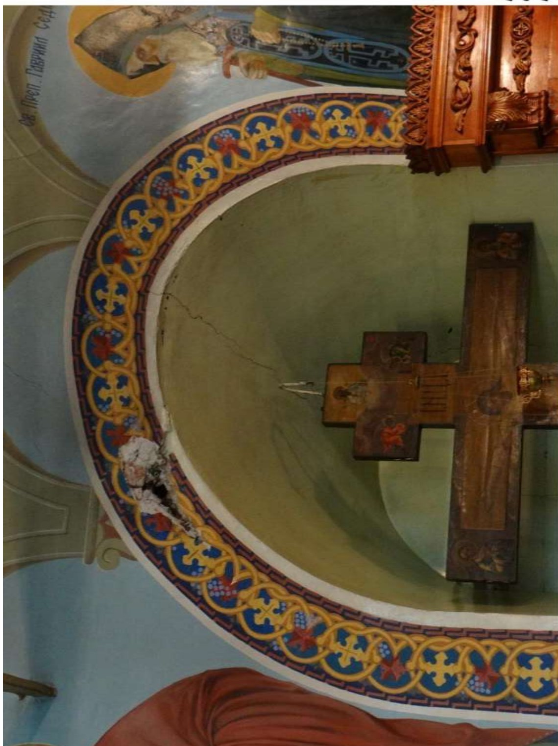
Нижний храм. Северная стена трапезной. Трещины и разрушения.
