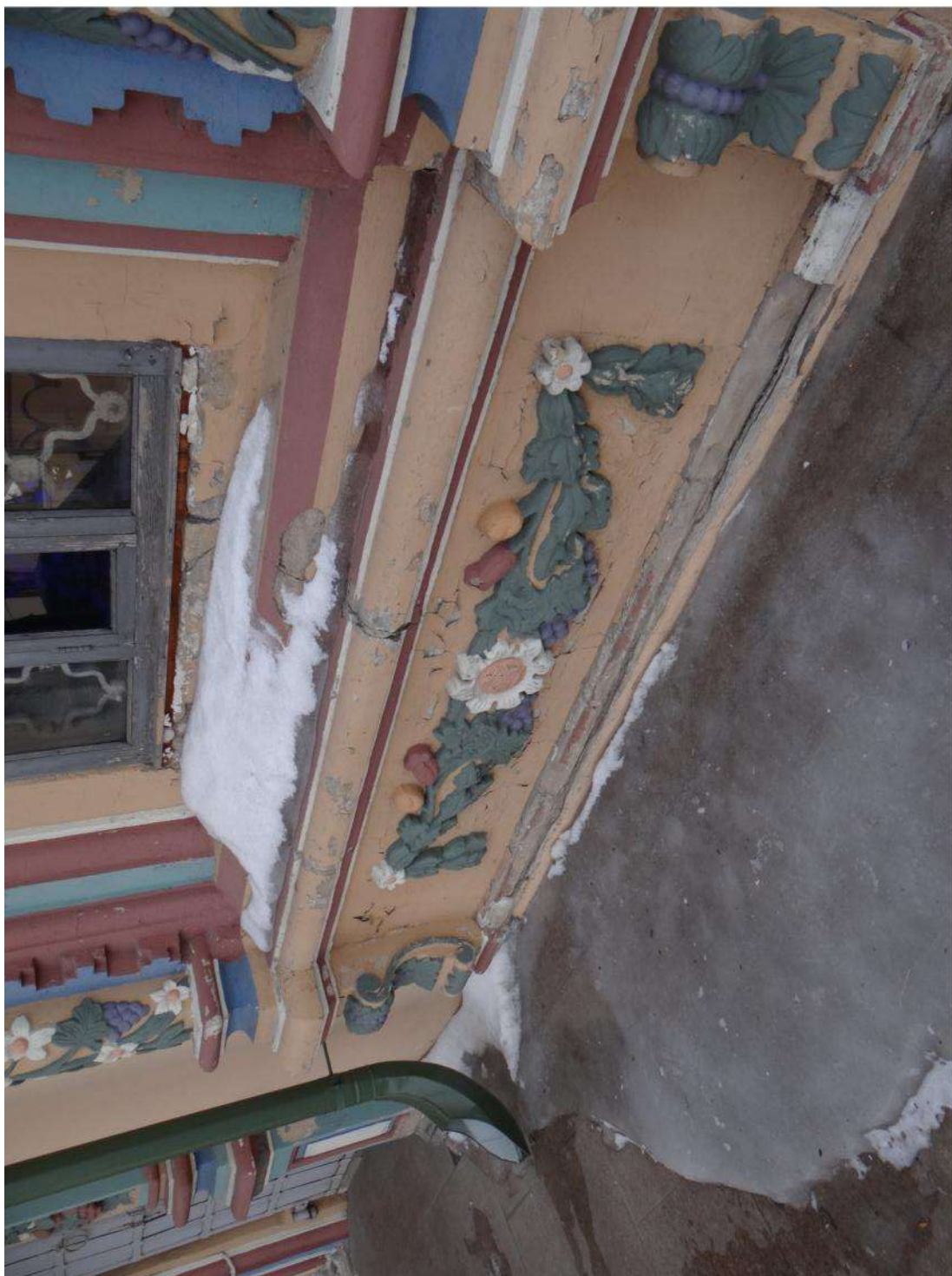
Северная паперть собора. Трешины в оконном проеме и разрушения лепного и белокаменного декора из-за неправильного отведения воды.
