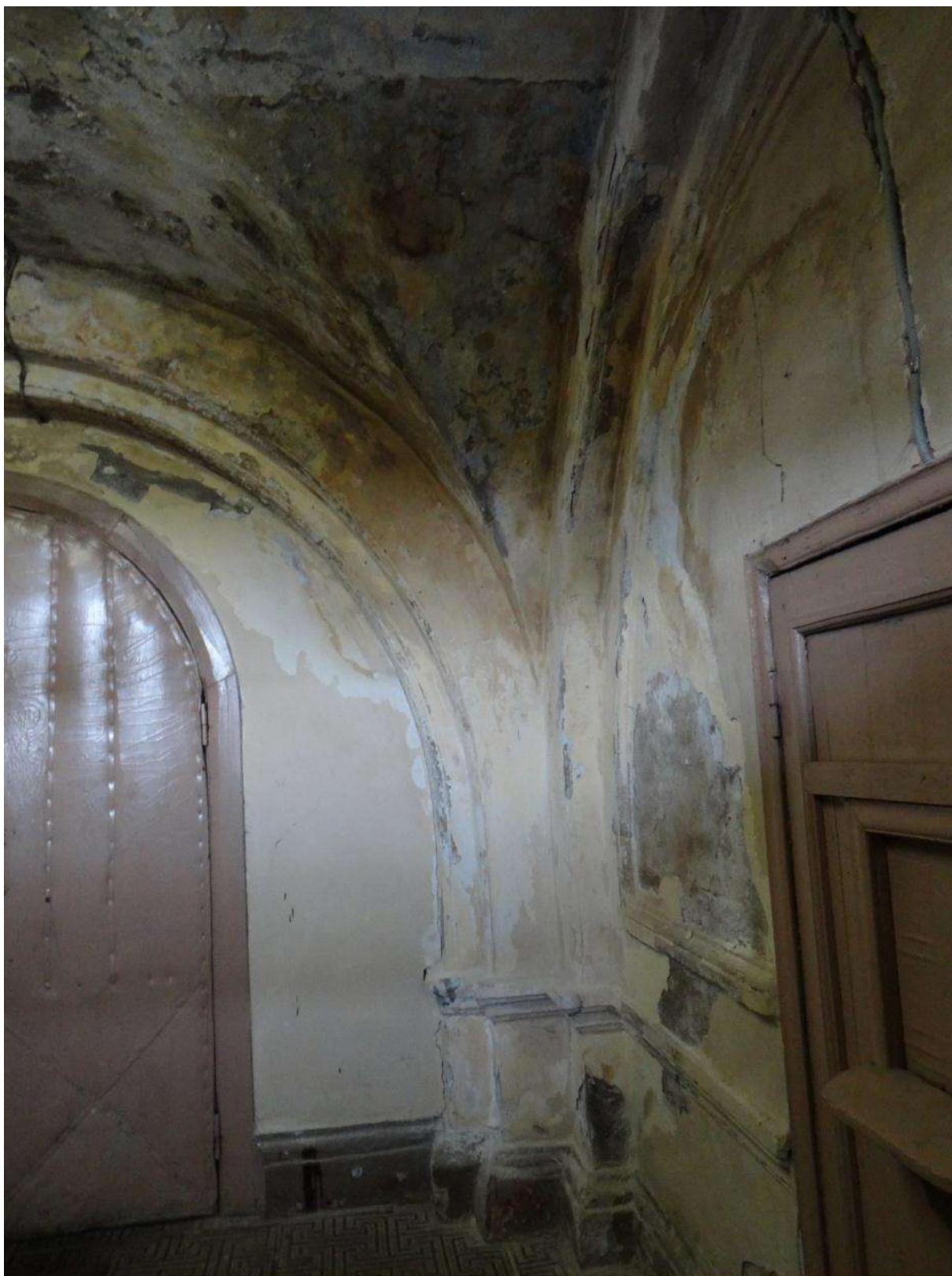
Помещения под папертью. Результат систематических протечек из-за неправильного устройства гидроизоляции паперти.
