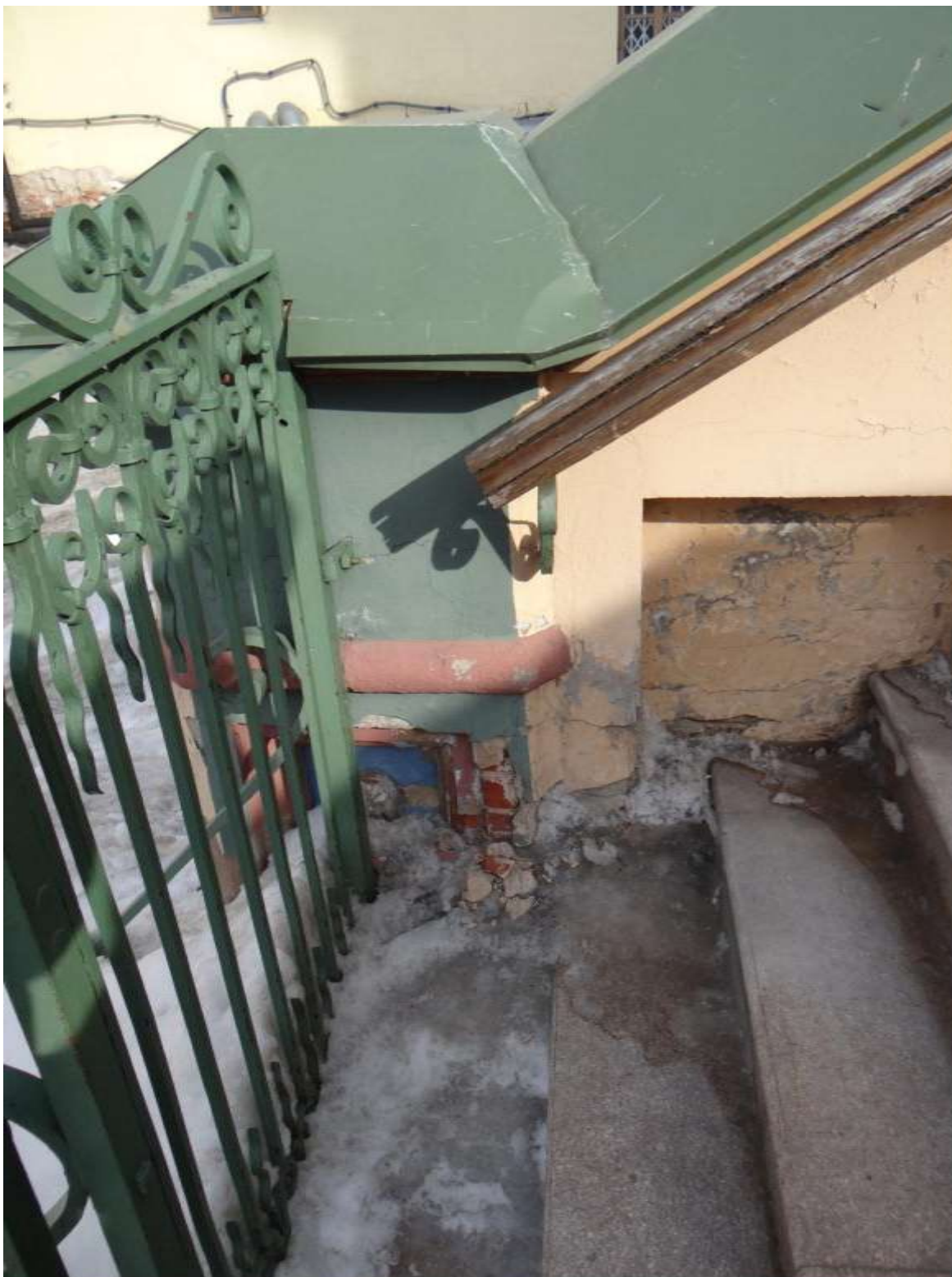
северная лестница. разрушения парапетной стенки из за неправильного отведения воды
